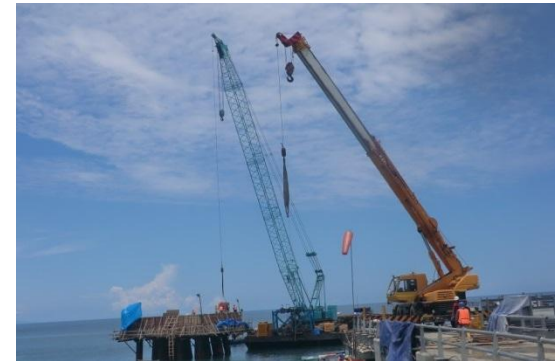
Pouring Concrete Pile Cap MD-1
